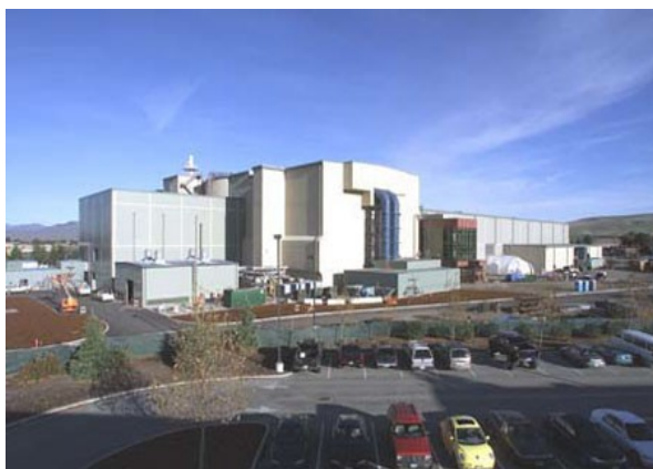
Rys.5. Budynek wielkiego systemu laserowego NIF w Livermore (USA) uruchomionego w 2009r, przeznaczonego do badań syntezy laserowej..
